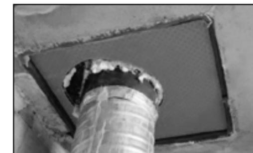
■ Enlever le couvercle, les cloisons de renforcement et les montants. Découper le fond et les aciers de renfort le cas échéant, passer le fourreau, puis reboucher la réservation avec du béton.
