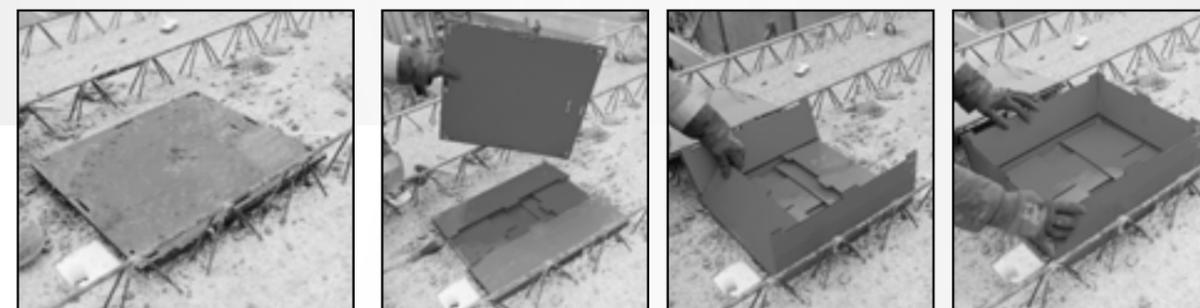
■ Dévisser le couvercle à l'aide d'un tournevis cruciforme. Puis déplier la RézaSure pour coffrer la réservation.
