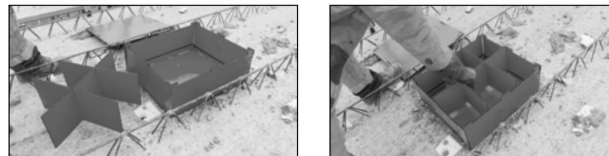
■ Mettre en place les cloisons de renforcement au centre de la RézaSure.
