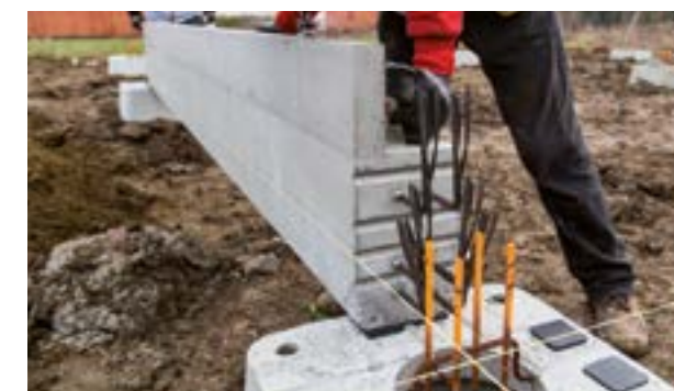
■ Pose des longrines en périphérie, sur plots coulés ou préfabriqués SIP
