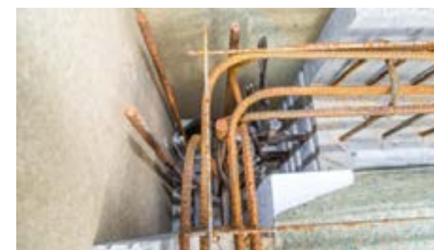
■ Pose des aciers complémentaires selon le plan de pose.
