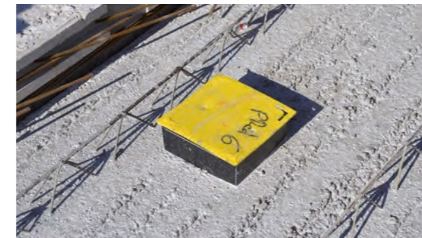
■ Fermeture de la boîte avant bétonnage de la Prédalle de compression.
