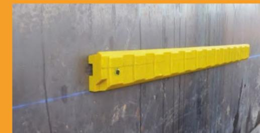
■ Posez les règles en prenant soin de placer la sous-face de la règle juste sur le trait de niveau de référence. Puis graisser la banche avec la règle avant de mettre la boîte d'attente et les armatures.
