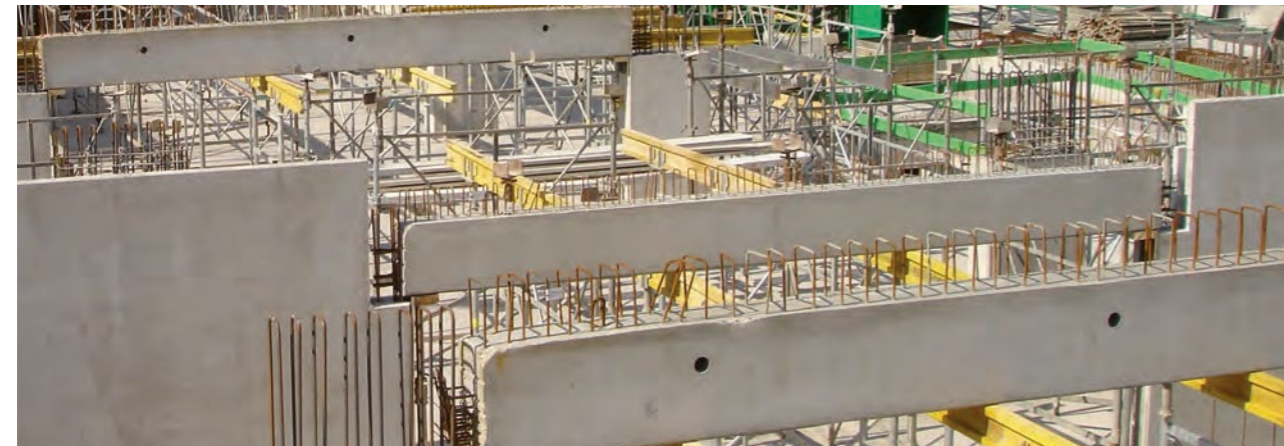
■ Repos sur appui.
