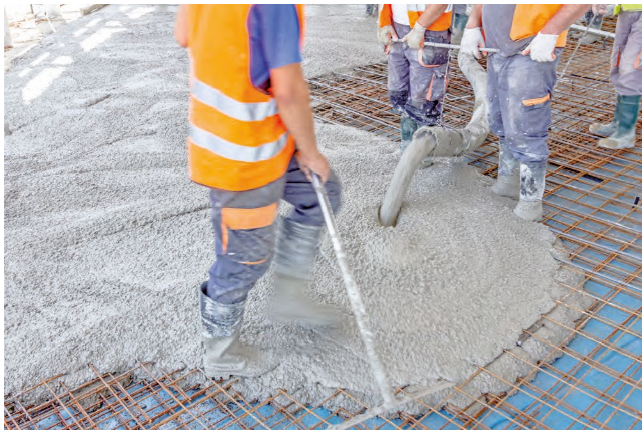
■ Coulage de la dalle de compression.
