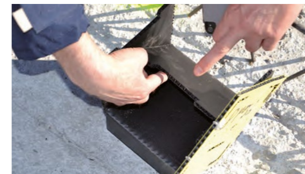
■ Dépliage de la boîte pour assurer le coffrage de la trémie au-dessus de la Prédalle.
