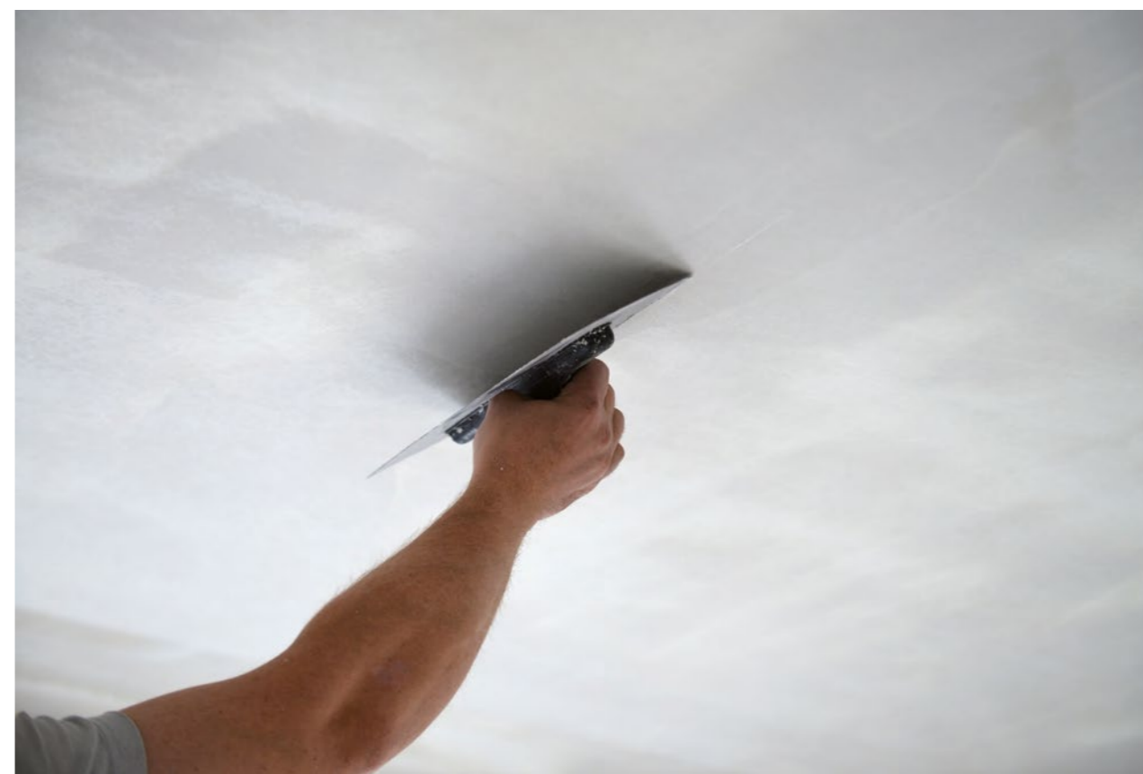
■ La qualité de sous-face et la planéité des Prédalles BA facilitent les travaux de finition et de peinture.
