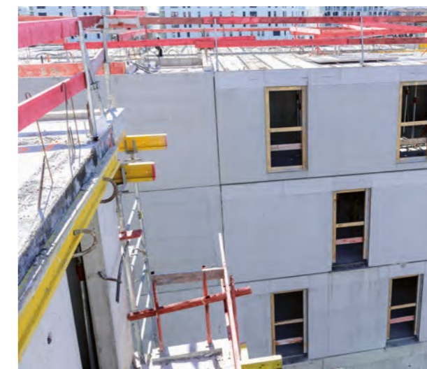
■ Coffrage bois sur chantier.
