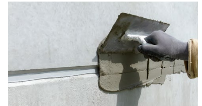
■ Pose de mortier.
