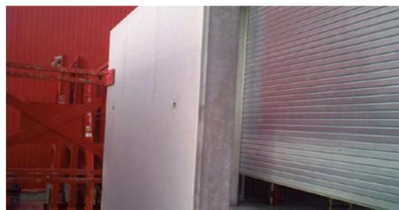
■ **Coffrage d'about de voile (about coffré en usine).** Cette technique dispense de coffrer les rives sur le chantier. L'about coffré est mis en place sur demande au moment de la préfabrication en usine et offre une haute qualité de finition.
