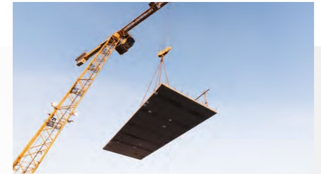
■ Levage Prédalle BA.
