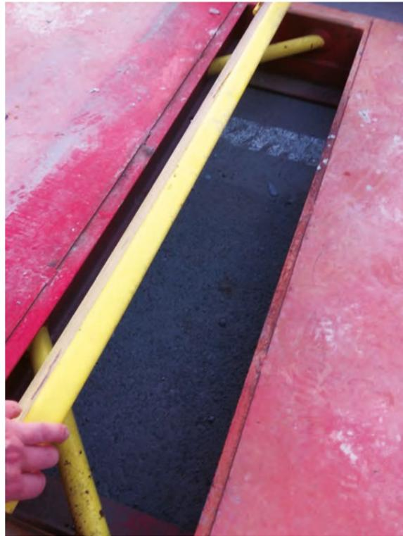
**Levage du rack vide en se fixant sur les barres jaunes (uniquement accessibles lorsque le rack ne contient plus de Prémur).**
