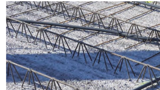
■ Faites passer les gaines et canalisations.
