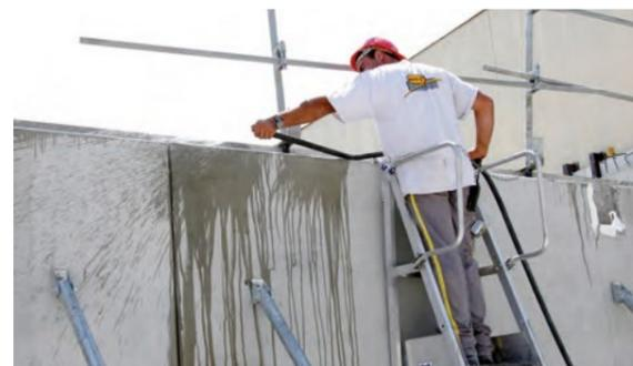
■ Avant de bétonner, mouillez l'intérieur des Prémurs.
