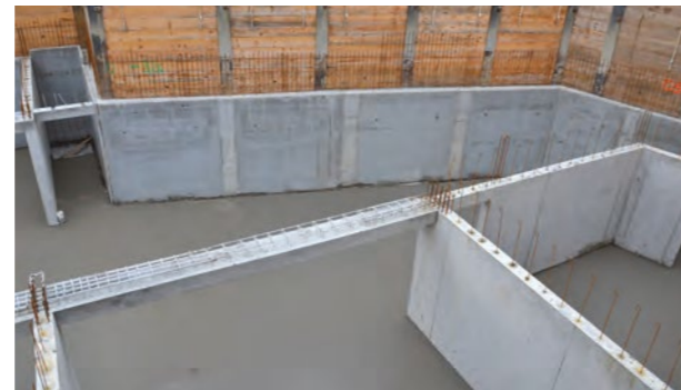
■ CoffraMur sur chantier
