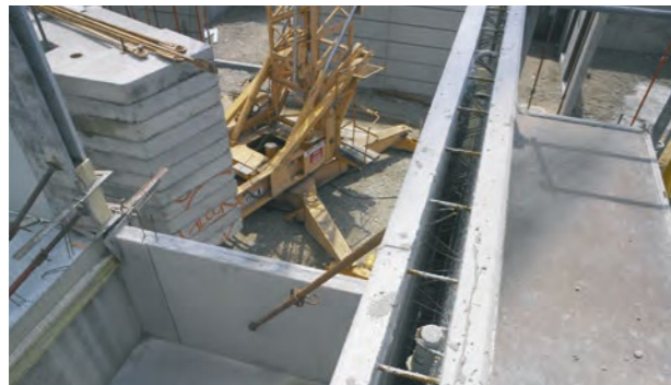
■ Sur un autre mur déjà stabilisé.
