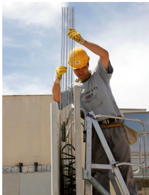
■ Mise en place des arrêts de bétonnage. L'arrêt de bétonnage peut être utile lorsque l'on souhaite différer la pose d'une partie des Prémurs. Il s'insère par le dessus et se plaque contre un raidisseur, de préférence au milieu du Prémur. En option, l'arrêt de coulage peut, à la demande de l'entreprise, être intégré au Prémur lors de la fabrication.
