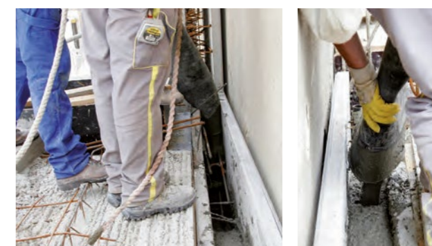
■ Bétonnage du plancher.
