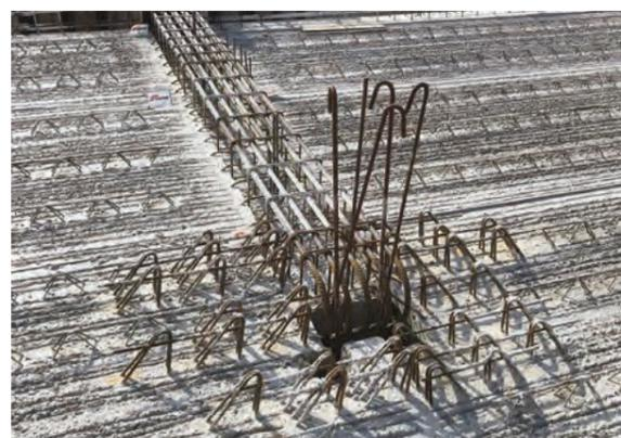
■ Détail des armatures anti-poinçonnement avant bétonnage de la dalle de compression.
