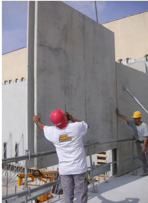
Après, il faut s'assurer de l'horizontalité du Prémur. Pour cela, le réglage s'effectue par l'ajout ou l'enlèvement de cales PVC. Il faut également s'assurer que toutes attentes en pieds soient à l'intérieur du Prémur. Une fois bien positionné et stabilisé (voir stabilisation [page 150](#)), le grutier peut relâcher la tension des élingues en posant complètement le Prémur sur les cales.
