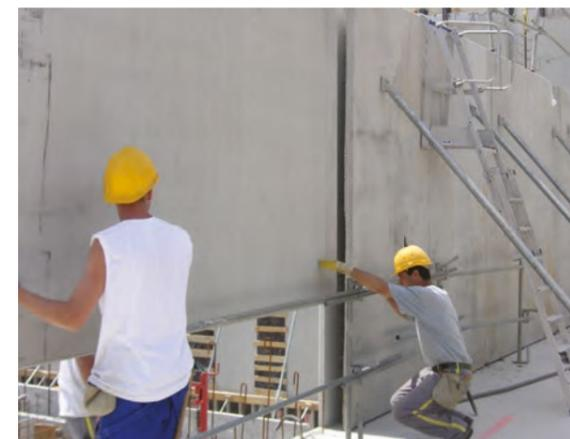
Une fois levé, la grue amène le Prémur au-dessus de son emplacement de pose, où une équipe généralement composée de 2 ou 3 personnes l'attend. Elle s'assure du bon positionnement du Prémur par rapport aux limites tracées en amont.
