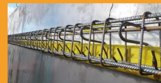
■ Ferraillez le voile, passez un acier filant dans la boucle de la boîte d'attente, fermez la banche et bétonnez le voile.
