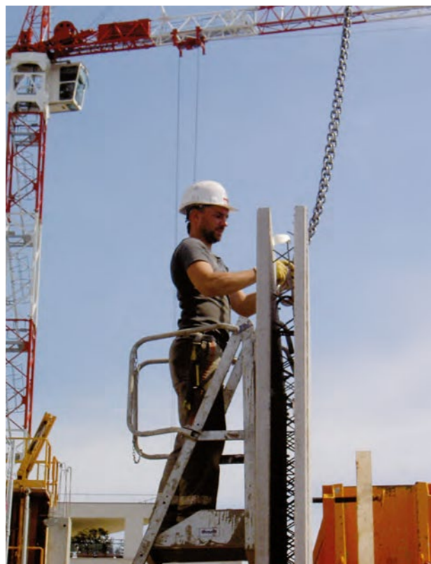
■ Mise en place des arrêts de bétonnage. L'arrêt de bétonnage peut être utile lorsque l'on souhaite différer la pose d'une partie des Prémurs. Il s'insère par le dessus et se plaque contre un raidisseur, de préférence au milieu du Prémur. En option, l'arrêt de coulage peut, à la demande de l'entreprise, être intégré au Prémur lors de la fabrication.
