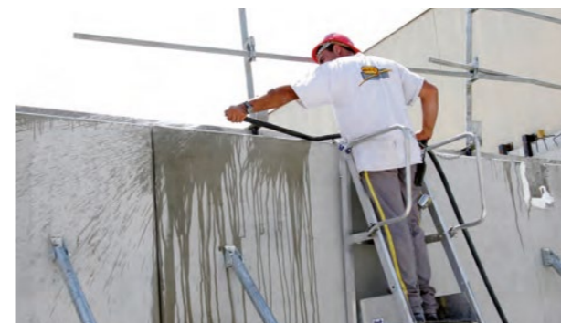
■ Avant de bétonner, mouillez l'intérieur des Prémurs.
