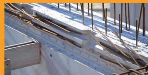
■ Une fois la boîte d'attente décoffrée, il suffit pour retirer la règle d'introduire un marteau dans la réservation et faire pivoter la règle vers le haut pour la décoffrer. Après avoir posé et réglé l'étalement, il reste à poser la Prédalle contre les butées béton qui garantissent le bon positionnement des Prédalles.
