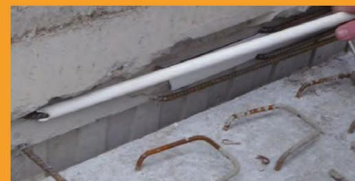
■ Dépliez les attentes. Puis enfiler les aciers de chaînage et couture conformément au plan de pose et bétonnez la dalle de compression.
