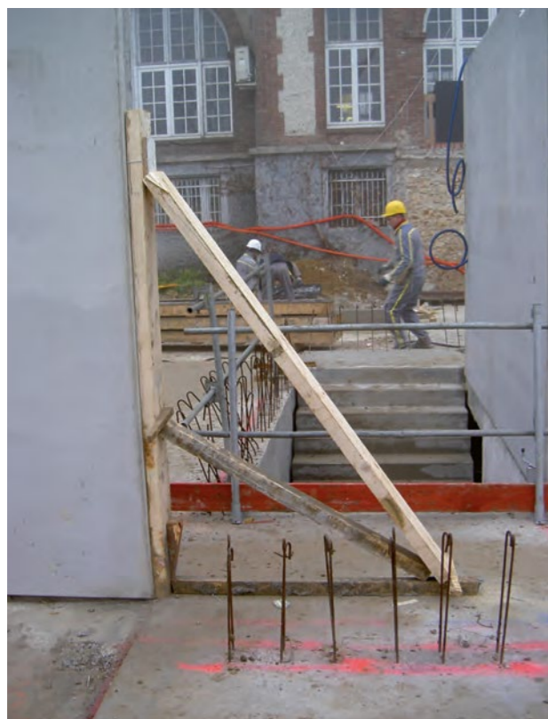
■ Coffrer les rives (mise en place d'un mannequin).
