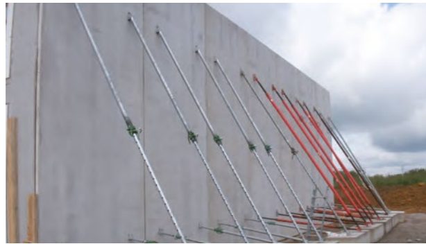
■ Sur un lest en béton équipé d'un deuxième étau horizontal.
