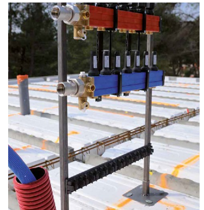
■ Support de collecteurs provisoires
