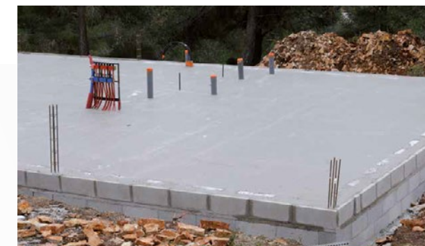
■ Déverser et vibrer le béton de façon uniforme à partir des appuis vers le centre, pour éviter toute concentration de poids.
