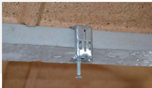
■ Appui sur la poutrelle.
