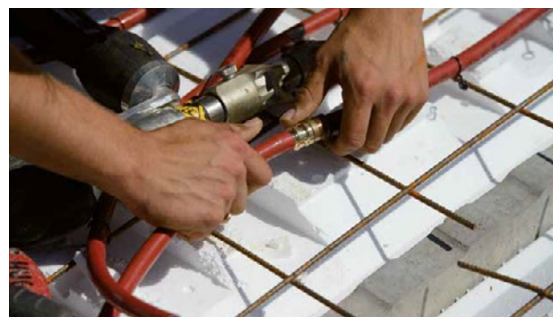
■ Une fois le plancher posé, mettre en œuvre les modules de plancher chauffant / rafraîchissant selon le plan fourni par REHAU.
