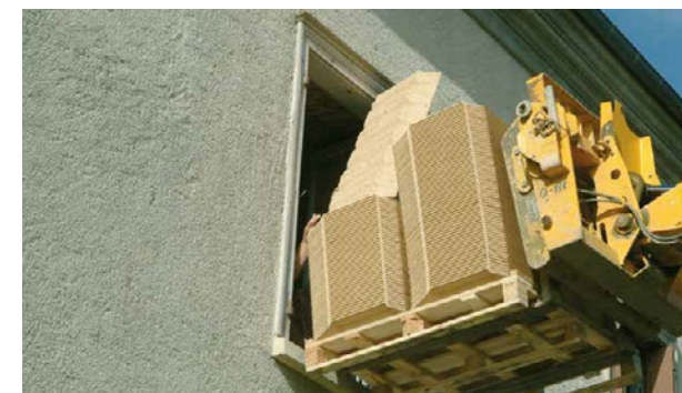
■ Passage des entrevous par les fenêtres.
