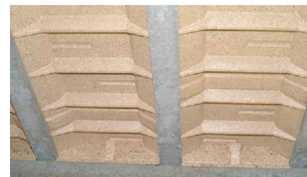
■ Bonne étanchéité au coulage.
