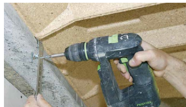
■ Vissage de la suspente.
