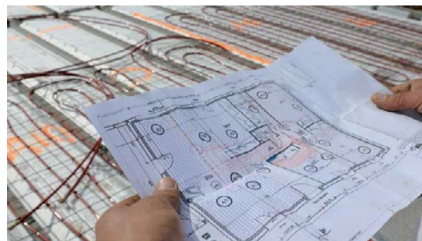
■ Une fois le plancher posé, mettre en œuvre les modules de plancher chauffant / rafraîchissant selon le plan fourni par REHAU.
