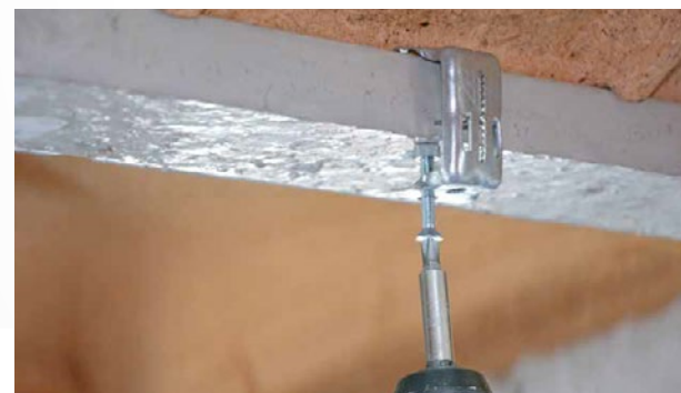
■ Vissage contre la poutrelle.
