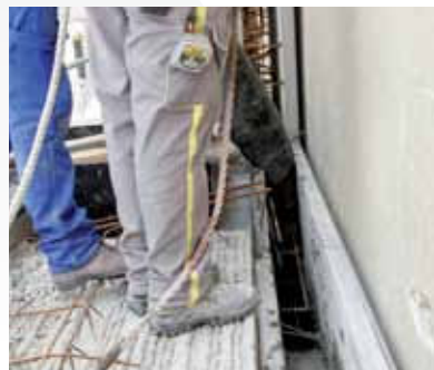
■ Bétonnage du plancher.
