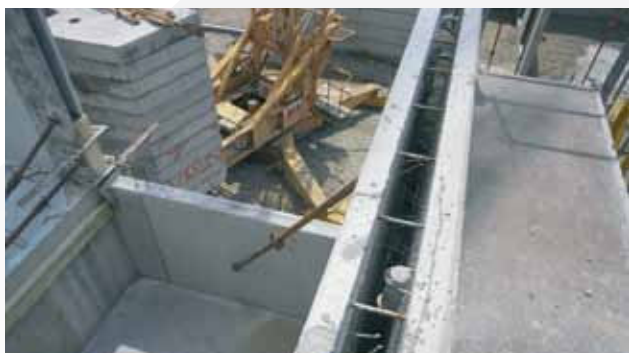
■ Sur un autre mur déjà stabilisé.
