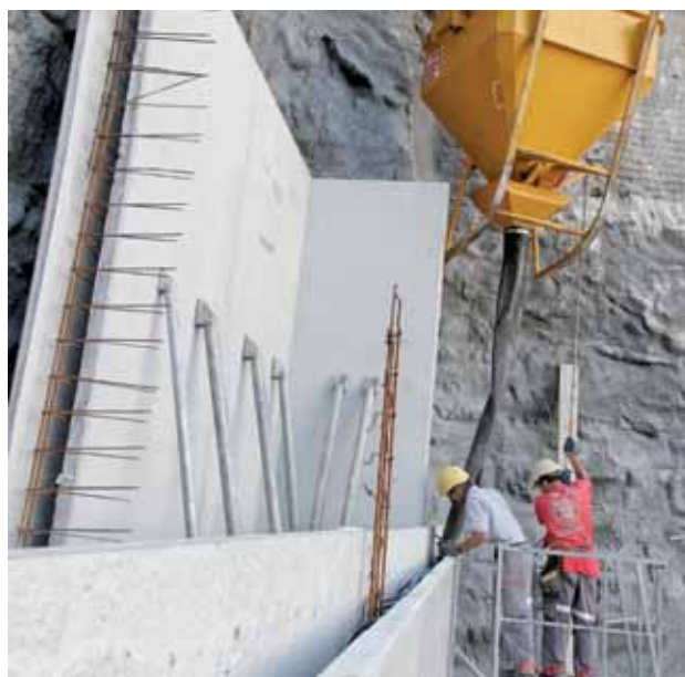
■ Échafaudage ou nacelle automotrice.
