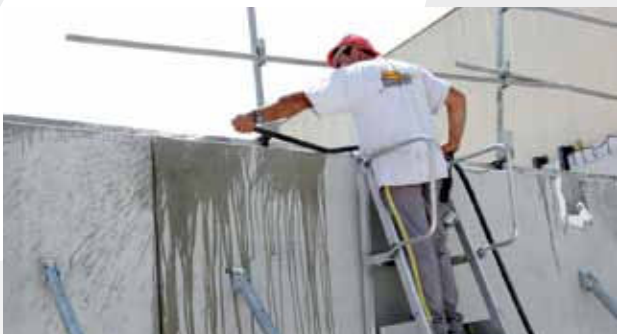
■ Avant de bétonner, mouiller l'intérieur des Prémurs.
