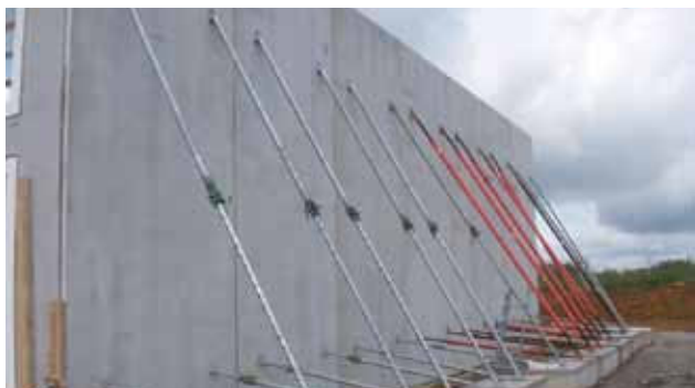
■ Sur un lest en béton équipé d'un deuxième étau horizontal.
